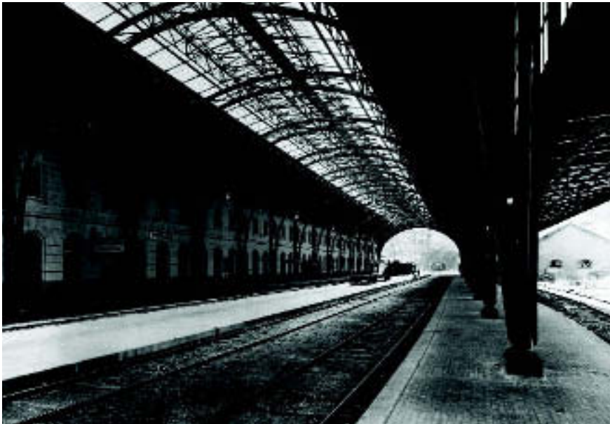
Interior de la estación de Portbou, al pie de los Pirineos, en la frontera con Francia. A causa de los controles fronterizos y de la diferencia de ancho de vía, la estación de Portbou fue y todavía es punto de transbordo de mercancías y viajeros entre España y Francia. La conexión transfronteriza con el ancho de vía europeo no ha llegado todavía.
