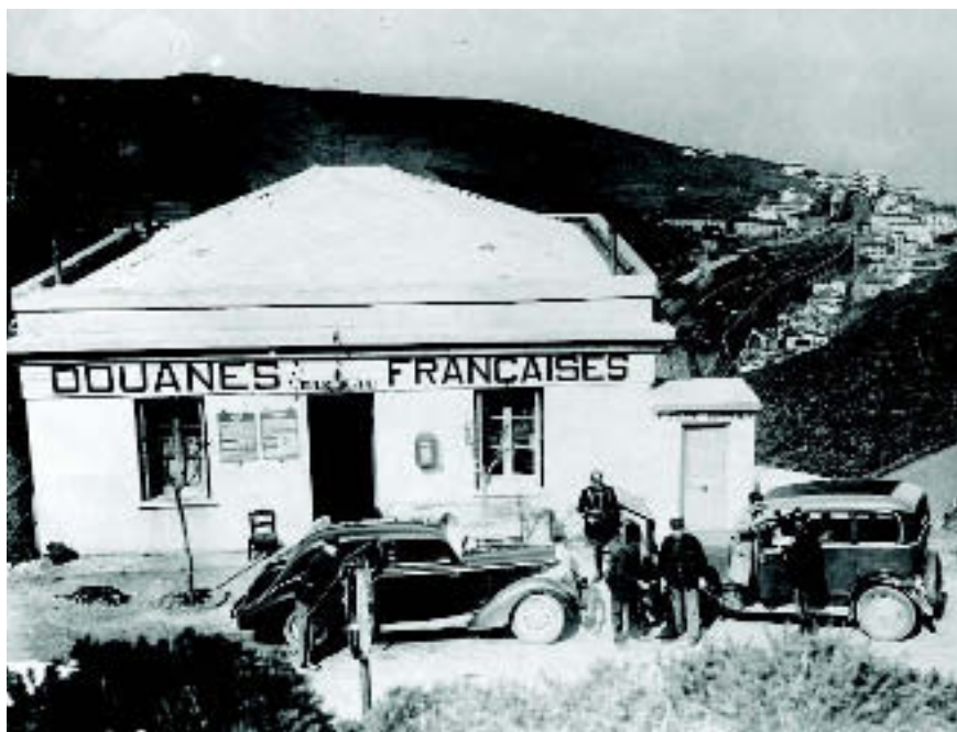
Punto de control y oficina del Comité de No Intervención en Cerbère, durante la Guerra Civil (1937).
